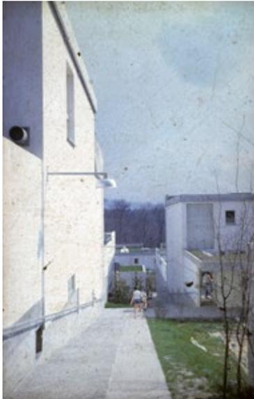
Verputzte und weiss gestrichene Fassaden aus Durisol-Dämmstein
